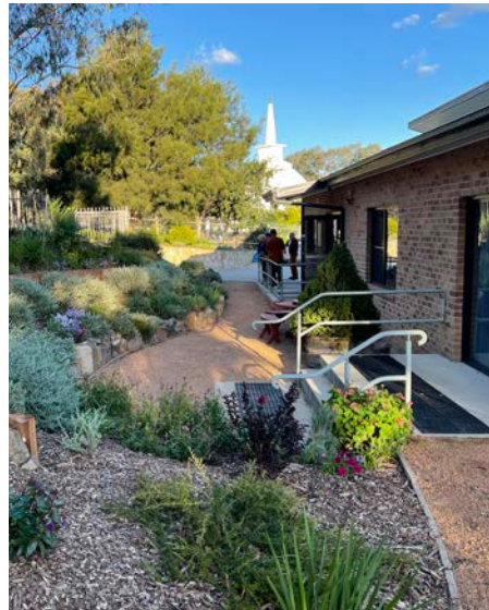
Pintu masuk ke Hall Subud Canberra
